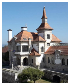
Hospital casa-asilo Centro Cultural XXIII EXFIMIÑO 2019
